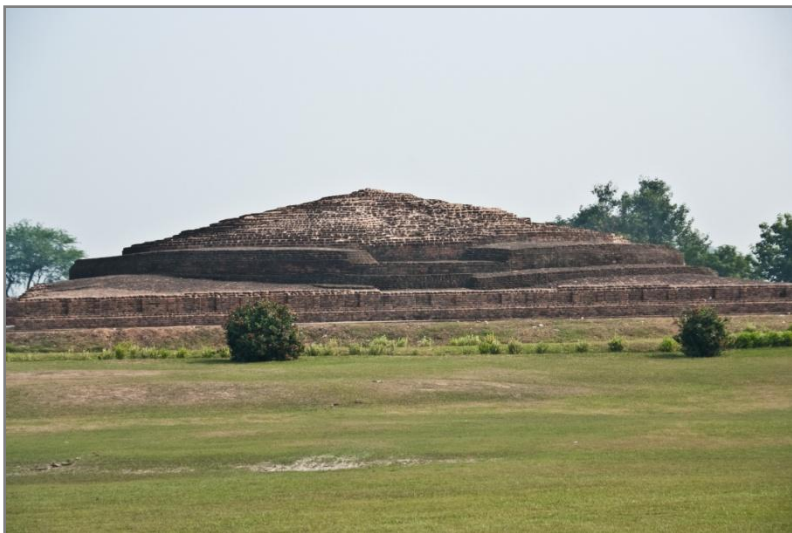
Tàn tích cổ thành Kapilavatthu được trùng tu Piprahawa, Lumbini, Nepal
